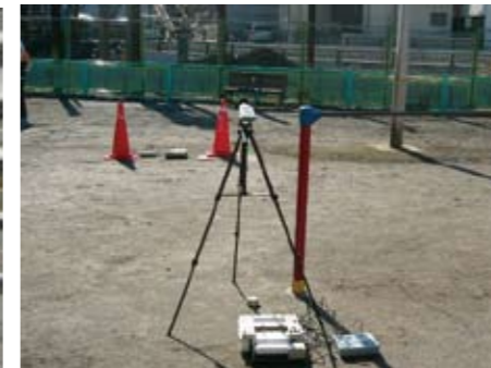
特定建設作業 騒音振動調査状況
